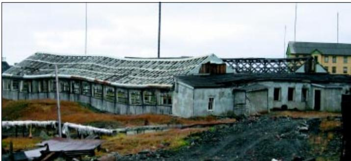
**Abb. 9:** Durch Rückgang des Permafrosts verformte Häuser in Tiksi (Sibirien) (Foto: H. Lantuit, AWI Potsdam).
