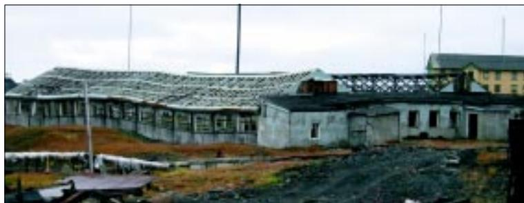
Abb. 3: Durch Rückgang des Permafrosts verformte Häuser in Tiksi (Sibirien) (Foto: H. Lantuit).
