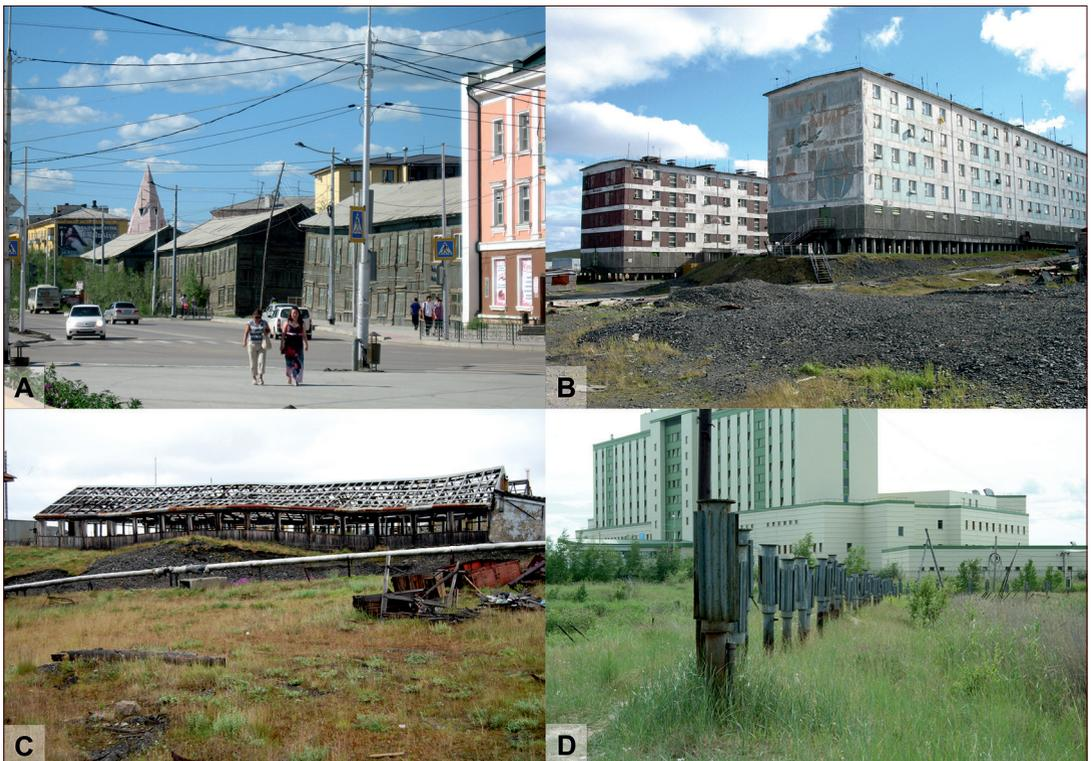
**Abb. 7.3-5:** Permafrost und Infrastruktur: (A) Durch Permafrostdegradation deformierte Gebäude neben neuen permafrostgerecht gebauten Gebäuden in Jakutsk, (B) Gebäude auf Pfählen zur Kühlung des Permafrostes, (C) Durch Permafrostdegradation deformiertes und zerstörtes Gebäude in Tiksi, (D) Thermosyphons zur Kühlung eines Wasserdamms in unmittelbarer Nähe zum modernen Krankenhaus von Jakutsk (Fotos: (A, D) M. Ulrich, (B, C) T. Opel).
