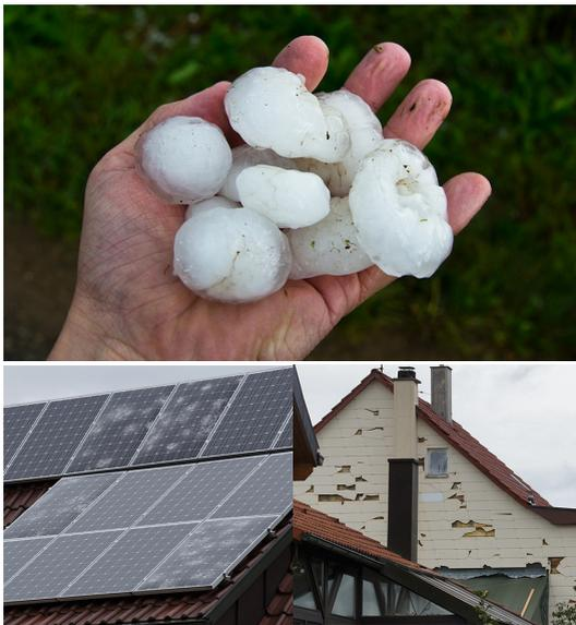
**Abb. 6.2-1:** Verschiedene Formen großer schadenrelevanter Hagelkörner (oben; [www.pixabay.com](http://www.pixabay.com)) und typische Schadenmuster an Gebäuden (hier nach dem schweren Hagelsturm in Reutlingen am 28.07.2013; unten, M. SCHMIDBERGER).
