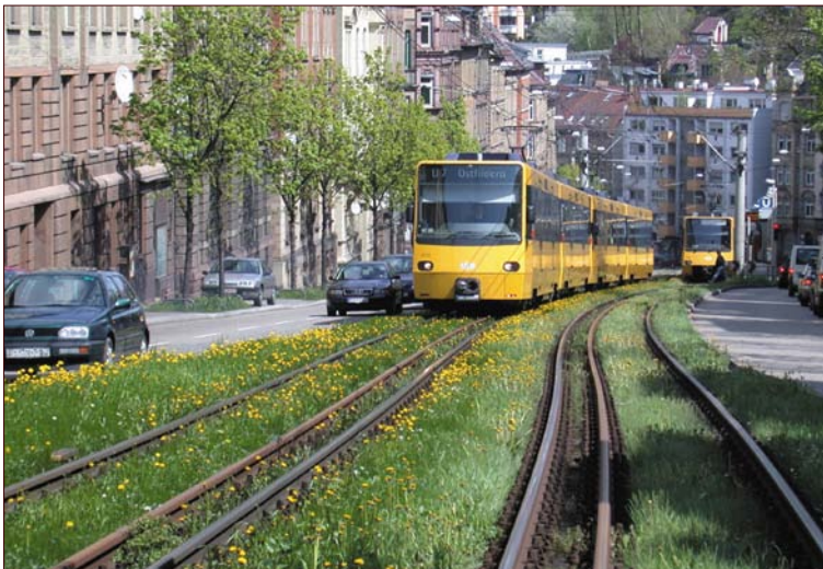
Abb. 3.1.1-8: Begrünte Gleisanlagen der Stadtbahn in Stuttgart.
