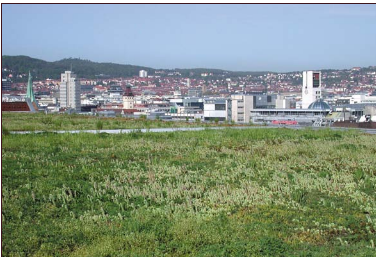
Abb. 3.1.1-9: Dachbegrünung in Stuttgart.
