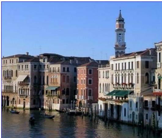
Abb. 5.5-5: Häuser am Canale Grande, Venedig.
