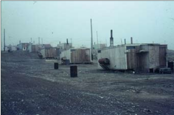
Abb. 1.5-2: Wohnhäuser (sog. »matchboxes«) in Cambridge Bay (Kanadische Arktis) mit Abfalltonne, Heizölbehälter, zwei Räume, kein Stromanschluss im Jahr 1970. (Fotos: Dietbert Thannheiser).
