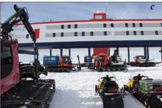
Abb. 5.1-6: a) Die Neumayer-Station III ist seit 2009 die permanent besetzte, zentrale wissenschaftliche und logistische Basis für das deutsche Polarprogramm (Foto: D. Steinhage, AWI). b) Das 2.300 t schwere Stationsgebäude wird von 16 hydraulisch steuerbaren Bipod-Zylindern getragen und in jeder Sommersaison angehoben (Foto: T. Matz, AWI). c: Neumayer-Station III, Fahrzeugpark für Traversen und wissenschaftliche Feldarbeiten (Foto: J. Asseng, AWI).
