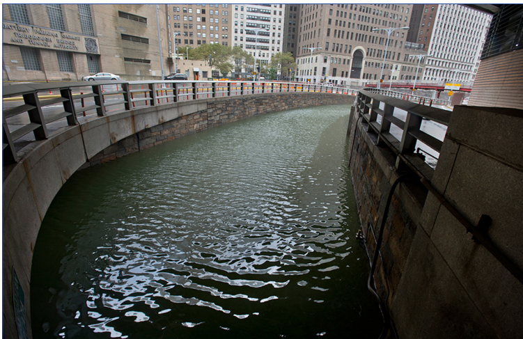
Abb. 3.2-2: Einfahrt zum Brooklyn-Battery-Straßentunnel, geflutet durch Hurrikan Sandy (Wikimedia Commons: Hugh L. Carey Tunnel during Hurricane Sandy, https://commons.wikimedia.org/wiki/File:Hugh_L._Carey_Tunnel_during_Hurricane_Sandy_vc.jpg , Lizenz: CC BY).
