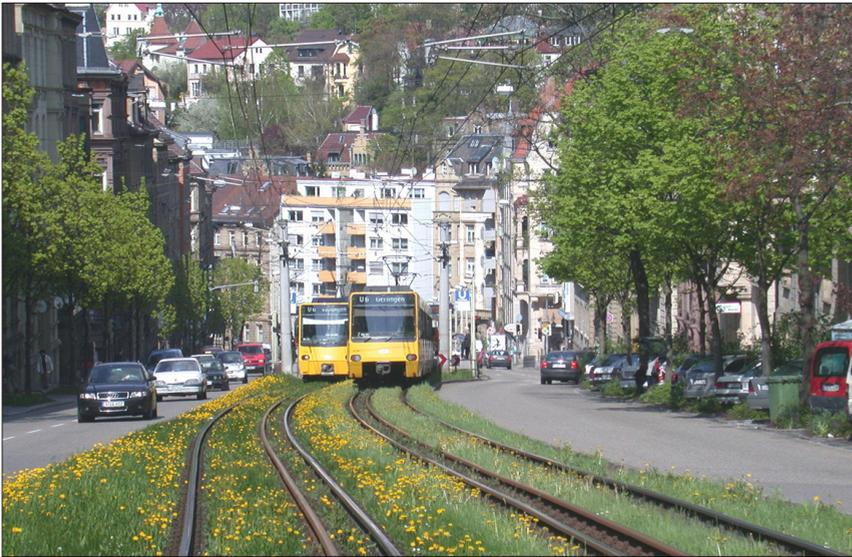
*Abb. 6.2-13: Begrünte Gleisanlagen in Stuttgart, (Foto: Baumüller).*
